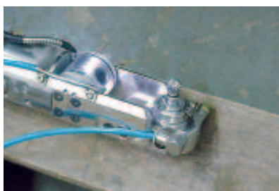
Robot s frézou na bezvýkopové otevírání stávajících odboček
