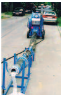
Tlakový buben s reverzačním zařízením
