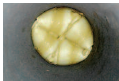
Reverzace tkaninového rukávce: Vnitřní strana tkaninového rukávce opatřená vrstvou lepidla se obrací působením tlaku a přichází do styku s vnitřní stěnou sanovaného potrubí
