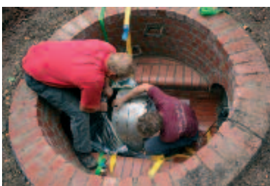
Uzavření rukávce speciální ucpávkou
