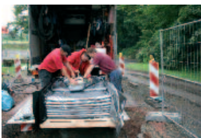
Pořizování spoje pro zatažení rukávce
