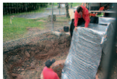
Zatahování rukávce napuštěného pryskyřicí do sanovaného úseku
