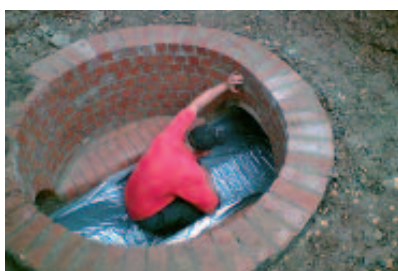
Příprava montáže speciální ucpávky
