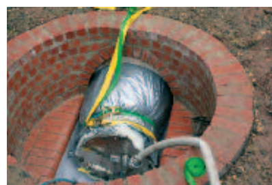
Tvarování rukávce tlakovým vzduchem
