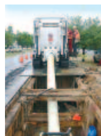
Reversační buben u startovací stavební jámy
