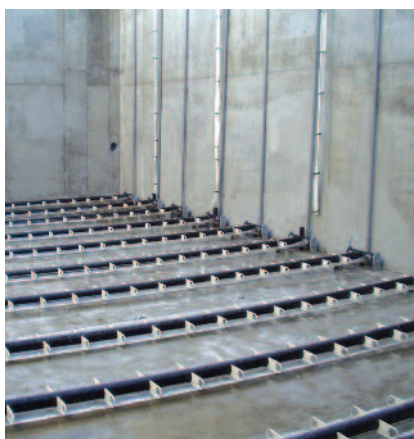
Provzdušňovací systém s perforovanou membránovou hadicí.
